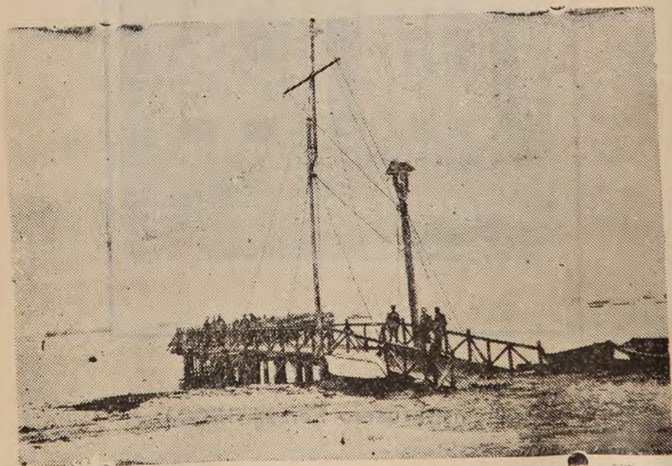
1.—Muelle de carga y vista del puerto.
