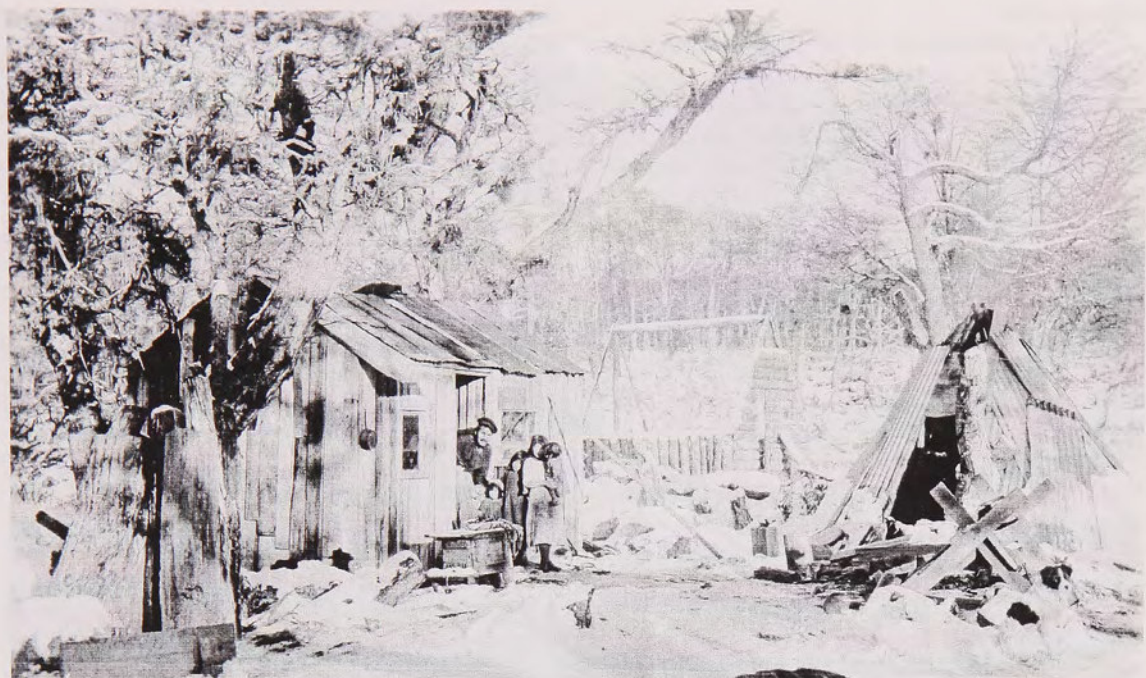
Fig. 4 Aspecto de parte de las construcciones existentes en Puerto Mejillones hacia 1920. Fotografía Kohlmann.
