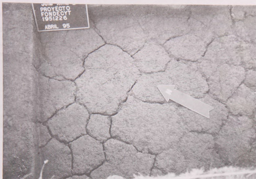
Fig. 8.- Grietas del estrato arcilloso
