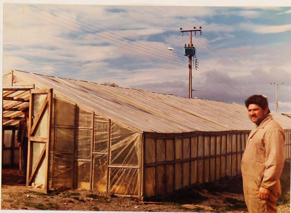
Figura 5 : Vista exterior invernadero Cema II
