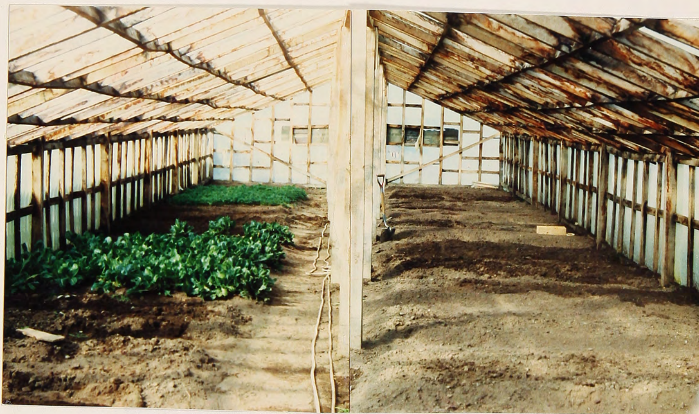
Figura 6 : Vista interior invernadero CEMA II
