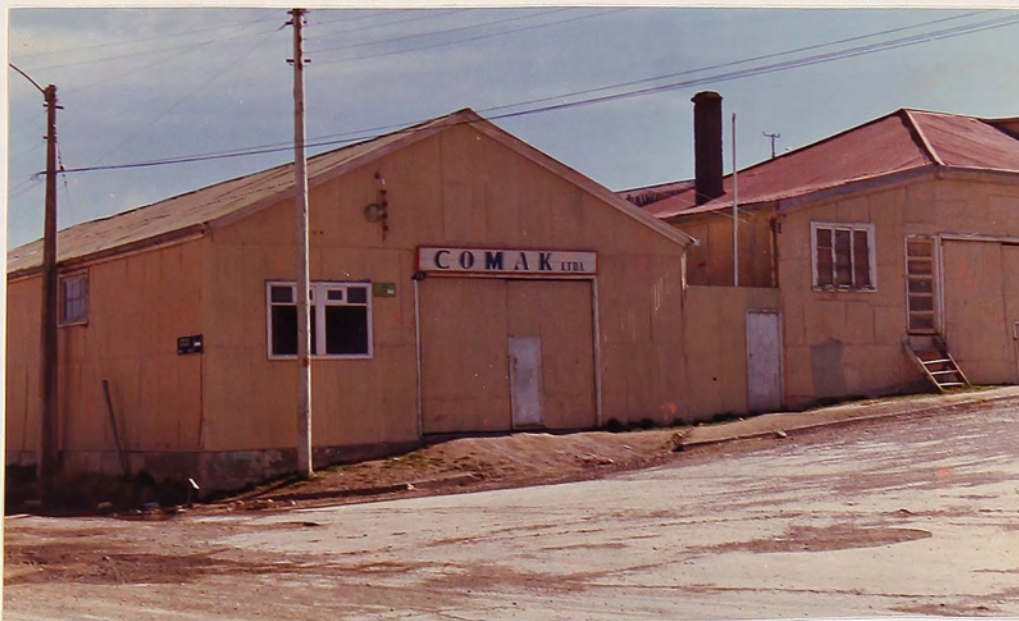
Figura 12 : Aspecto general externo de COMAK
