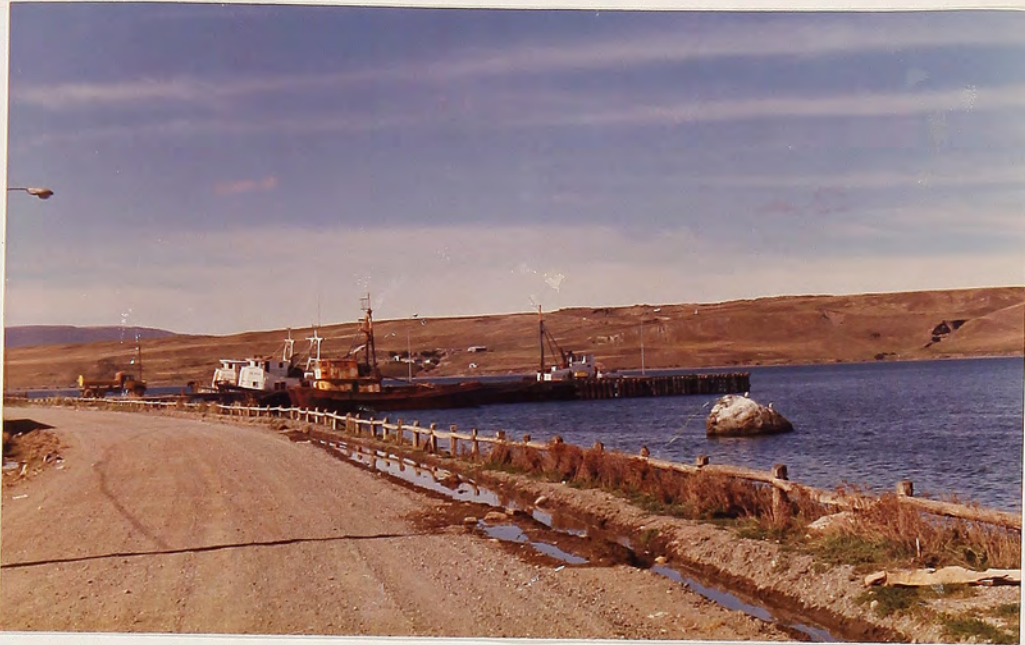
Figura 9 : Muelle fiscal en la ciudad de Porvenir. Facilidades basicas de electricidad y agua potable.
