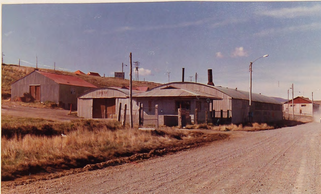
Figura 11 : Vista general externa de la conservera COPETIF.
