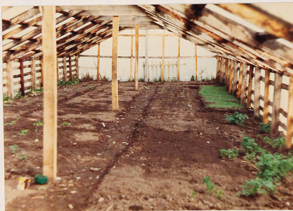
Figura 4 : Vista interior invernadero CEMA I
